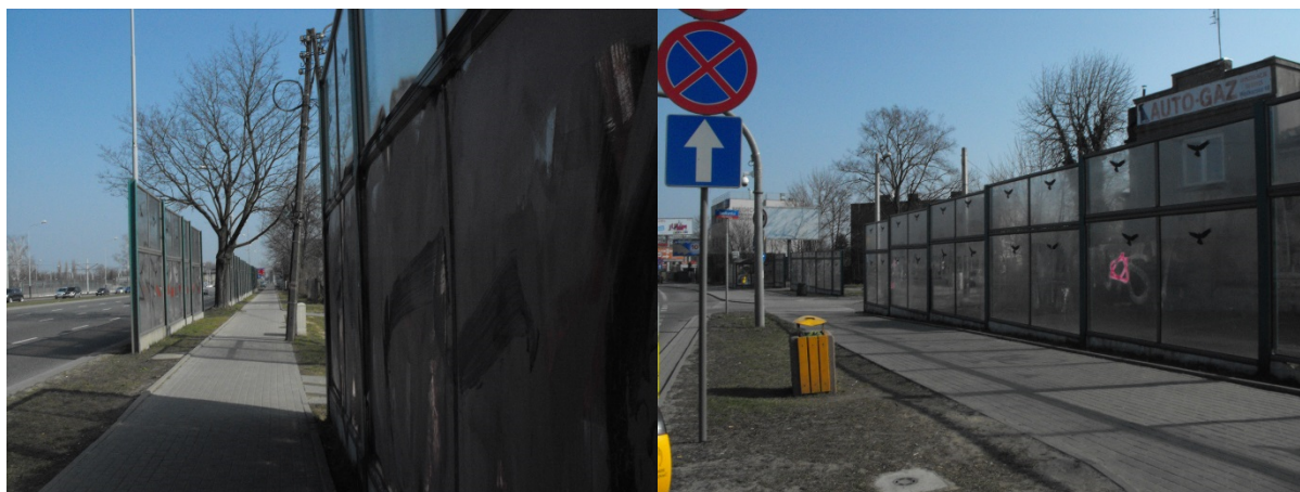
Rys. 1. Szklane ekrany akustyczne przy ulicy Pabianickiej w Łodzi
