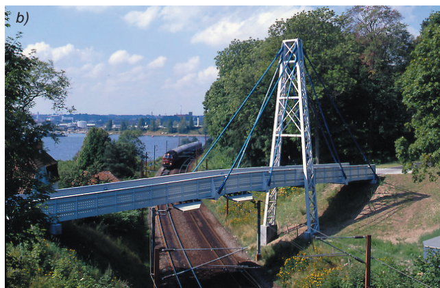
Rys. 1. Kładki dla pieszych wykonane z materiałów kompozytowych: a) Madrycie, b) Kolding (Dania) [2, 5]
