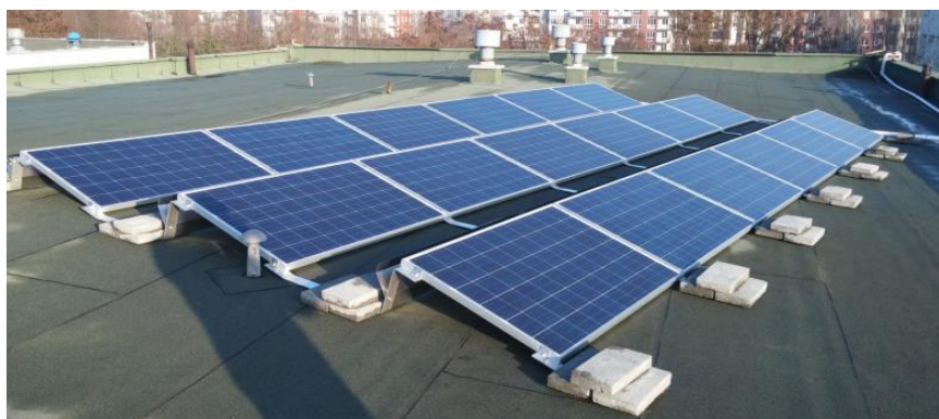
Rys. 11. Instalacja modułów polikrystalicznych na dachu WIM-UTP.
